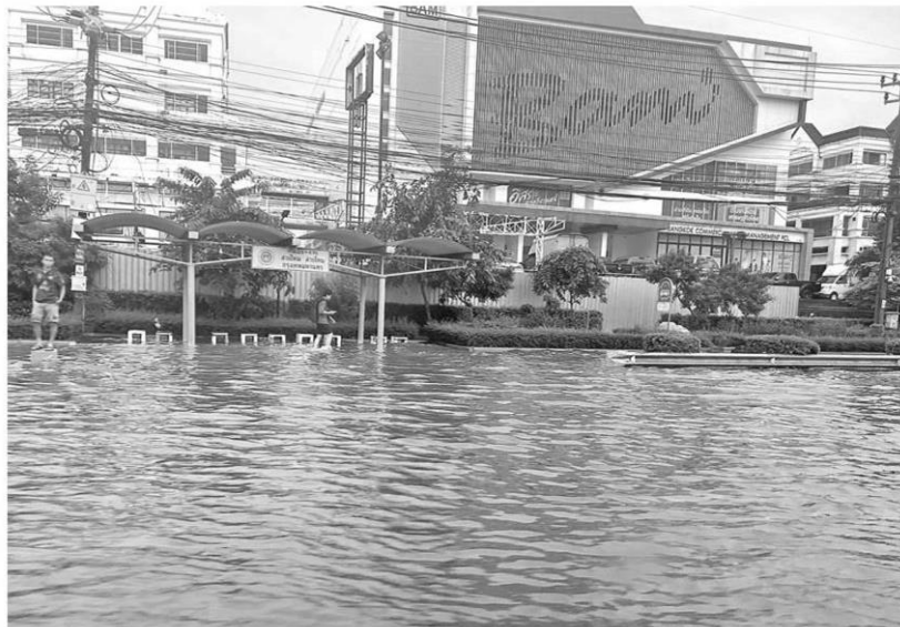
ที่บริเวณป้ายรถเมล์หน้าซอยพลโยธิน 62 เขตดอนเมือง น้ำยังท่วมสูงถึงฟุตบาท
