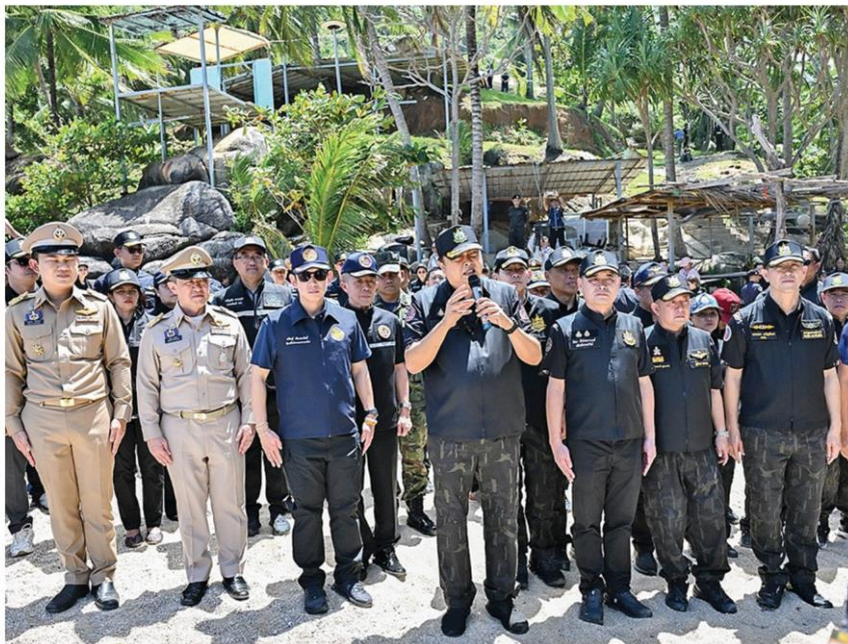
🏠 รุกหาดนุ้ย - นายสุชาติ ชมกลิ่น รมว.ทรัพยากรธรรมชาติและสิ่งแวดล้อม นำเจ้าหน้าที่กว่า 200 นาย รื้อสิ่งปลูกสร้าง 11 จุดรื้อรื้อ รื้อสร้างรื้อสร้างชายหาดนุ้ย ซึ่งอยู่ในพื้นที่ป่าสงวนแห่งชาติป่าเทือกเขา นาคเกิด ต.กะรน อ.เมือง จ.ภูเก็ต เมื่อวันที่ 20 ก.ค.
