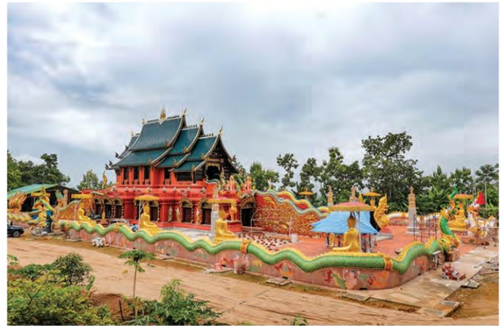
พระอุโบสถกำลังอยู่ระหว่างการก่อสร้าง
