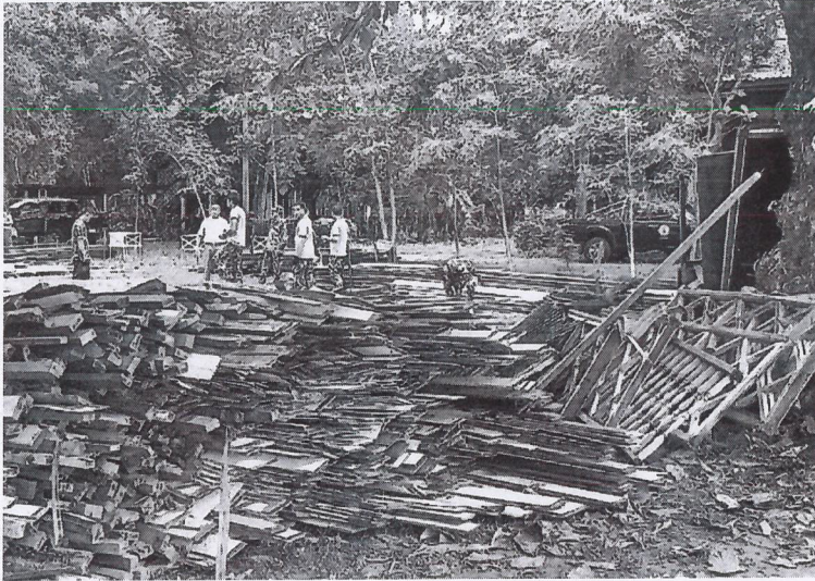
เหล็กล้วน - สภาพกองไม้ ที่ถูกรื้อถอนมาจากอาคาร บอมเบย์เบอร์มา หรืออาคารเขี้ยว สถาปัตยกรรมผสมผสานตะวันตก และตะวันออกอันล้ำค่า อายุ 131 ปี ภายในสวนรุกขชาติเขตรวัน ริม แม่น้ำยม อ.เมือง จ.แพร่ เมื่อวันที่ 18 มิถุนายน
