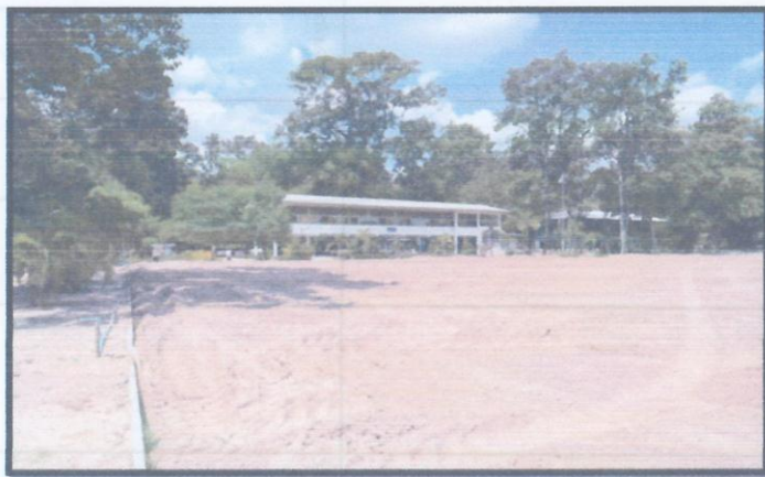
รูปถ่ายถมดินและปรับเกลี่ยเรียบรื้อแล้ว
