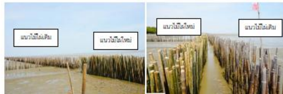
ภาพที่ 3 การปักแนวไม้ไผ่อันใหม่ ในพื้นที่ย่อยที่ 4 ตำบลนาโคก อำเภอเมือง จังหวัดสมุทรสาคร
