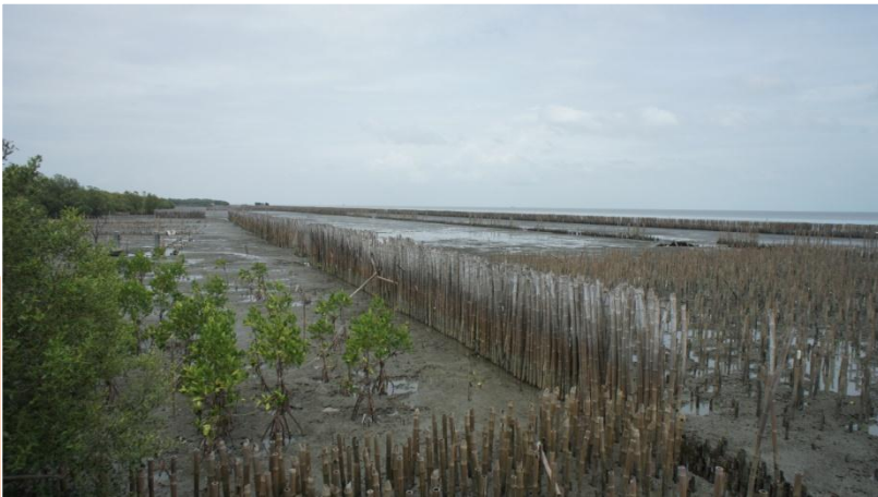
ม.3 ต.โคกขาม ถึง ม.8 ต.พันท้ายนรสิงห์ อ.เมือง จ.สมุทรสาคร (ดำเนินการในปี พ.ศ. 2550 และ 2552)
