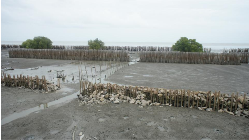
ม.8 ต.พันท้ายนรสิงห์ อ.เมือง จ.สมุทรสาคร (ดำเนินการในปี พ.ศ. 2553)
