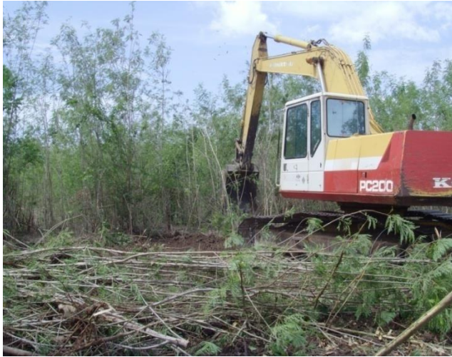
การเตรียมพื้นที่โดยใช้เครื่องจักรขนาดใหญ่
