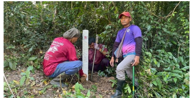
ติดตั้งหลักเขตป่าชุมชน ณ ป่าชุมชนบ้านแก่นมะพร้าว หมู่ที่ 5 ตำบลตะกุกใต้ อำเภอวิภาวดี จังหวัดสุราษฎร์ธานี
