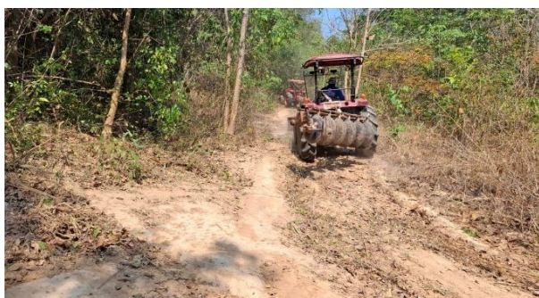
จัดทำทางแนวกันไฟ บริเวณปลูกไม้ใช้สอย บ้านคันโขง หมู่ที่ 1 ตำบลคันโขง อำเภอดุสิต จังหวัดพิษณุโลก
