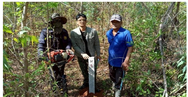
เจ้าหน้าที่ติดตั้งหลักเขตและป้ายป่าชุมชน ณ ป่าชุมชนบ้านหนองไผ่ หมู่ที่ 6 ตำบลนารวม อำเภอลาปาก จังหวัดนครพนม
