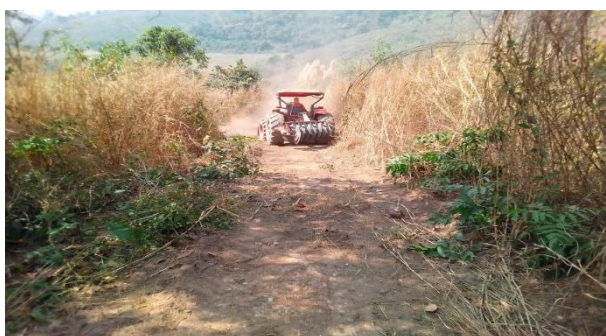
ทำทางตรวจการและแนวกันไฟ พื้นที่หน่วยพันฟูฯ ป่าแม่ยมตะวันตก ที่ 12 และ 14 จังหวัดแพร่
