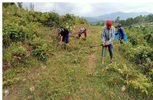
จัดทำทางตรวจการณ์ พื้นที่ตำบลสบโขง อำเภอมก๋อย จังหวัดเชียงใหม่
