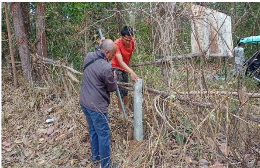
ติดตั้งหลักเขตป่าชุมชนบ้านโนนสำราญ หมู่ที่ ๘ ตำบลชุมระวี อำเภอจอมพระ จังหวัดสุรินทร์
