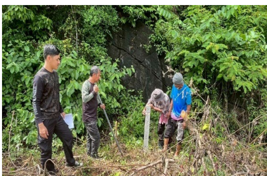
เจ้าหน้าที่ป่าชุมชนดำเนินการติดตั้งหลักเขตป่าชุมชน ณ ป่าชุมชนบ้านปีใหญ่ หมู่ที่ ๕ ตำบลกำแพง อำเภอละงู จังหวัดสตูล
