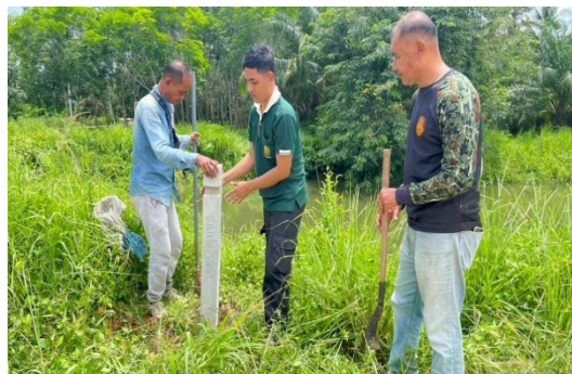
เจ้าหน้าที่ป่าชุมชนดำเนินการติดตั้งหลักเขตป่าชุมชน ณ ป่าชุมชนบ้านลุ่ม หมู่ที่ ๖ ตำบลท่าแพ อำเภอท่าแพ จังหวัดสตูล
