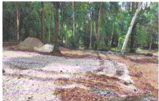
เตรียมพื้นที่สร้างลานจอดรถ ณ ศูนย์วนวัฒนวิจัยที่ ๓ (กำแพงเพชร)
