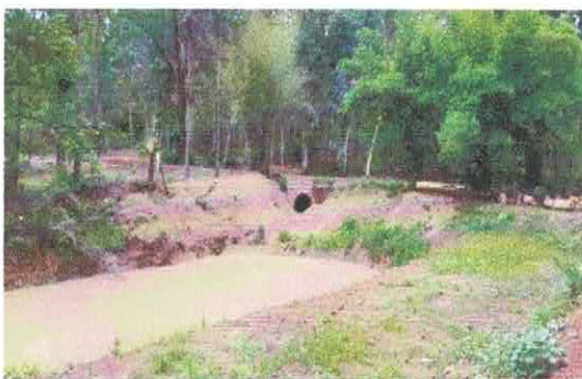
ขุด วาง ท่อระบบน้ำ ณ ศูนย์วนวัฒนวิจัยที่ ๓ (กำแพงเพชร)
