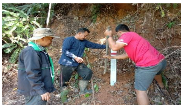
ติดตั้งหลักเขตป่าชุมชนบ้านโนนสมบูรณ์ หมู่ที่ 5 ตำบลภูเขาทอง อำเภอสุศรีริน
