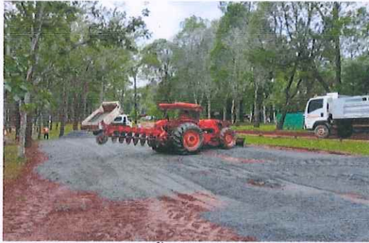
จัดสร้างลานจอดรถ พื้นที่สถานีวนวัฒนวิจัยบ่อแก้ว ตำบลบ่อหลวง อำเภอสอด จังหวัดเชียงใหม่
