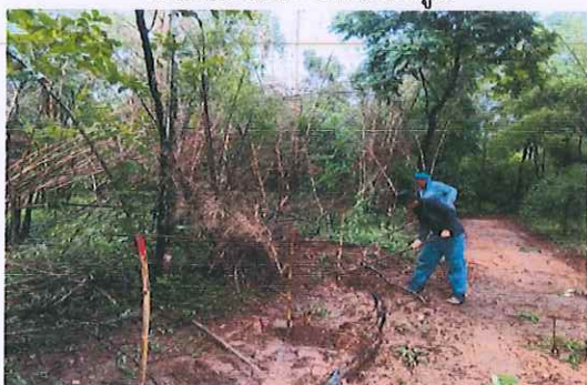
ขุดหลุมปลูก พื้นที่บ้านหนองปลาสะวาย หมู่ที่ ๒ ตำบลหนองปลาสะวาย อำเภอบ้านไผ่ จังหวัดลำพูน
