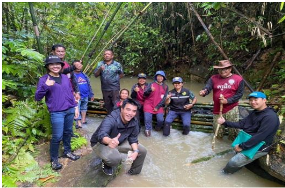
กิจกรรมก่อสร้างฝายต้นน้ำ เพื่อกักเก็บน้ำไว้ใช้ เพิ่มความชุ่มชื้น และดักตะกอนดิน
