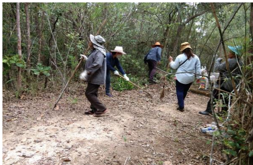
ปรับปรุงซ่อมแซมทางตรวจการณ์ บ.ชาติ ม.๗ ต.กระเดียน อ.ตระการพืชผล จ.อุบลราชธานี
