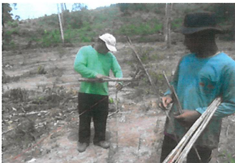
การทำหลักและปักหมยแนว
