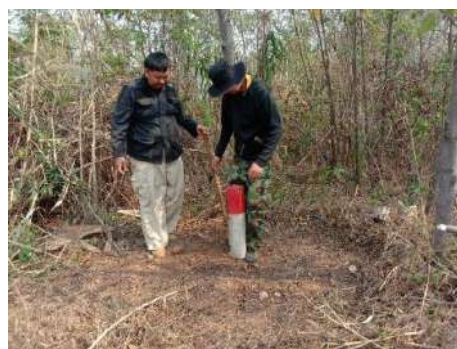
การทำทางตรวจการและแนวกันไฟ
