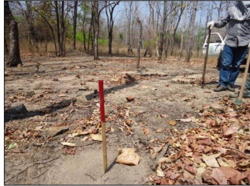
การสำรวจรังวัดเพื่อกำหนดจุดปักดในการฝังหลักเขตป่าสงวนแห่งชาติตามแผนที่ท้ายกฎกระทรวง
