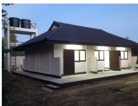
การก่อสร้างอาคารที่ทำการด้านป่าไม้
