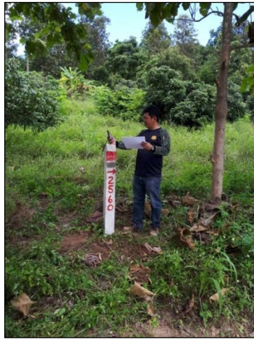
การสำรวจรังวัดเพื่อกำหนดจุดปักดในการฝังหลักเขตป่าสงวนแห่งชาติตามแผนที่ท้ายกฎกระทรวง
