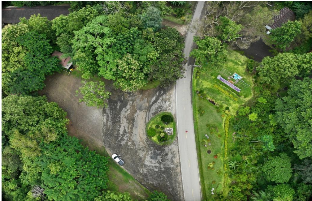
รูปที่ ๑.๓.๑-๗ สภาพพื้นที่ก่อสร้างบริเวณโซน F
