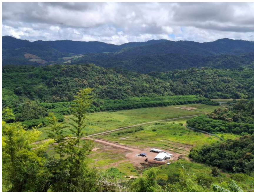
รูปที่ ๑.๓.๑-๔ สภาพพื้นที่ก่อสร้างบริเวณโซน C
