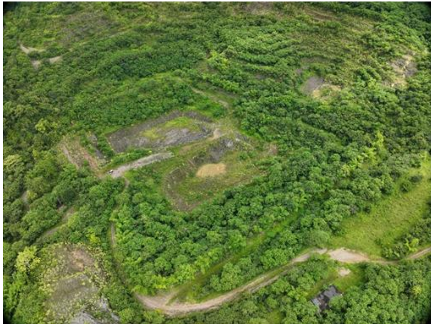
รูปที่ ๑.๓.๑-๓ สภาพพื้นที่ก่อสร้างบริเวณโซน AB
