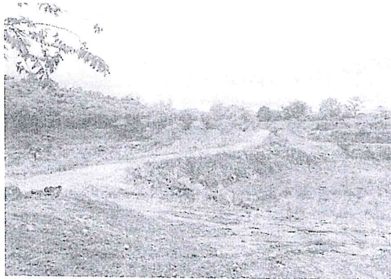
งาน Clearing พื้นที่หน้างาน
