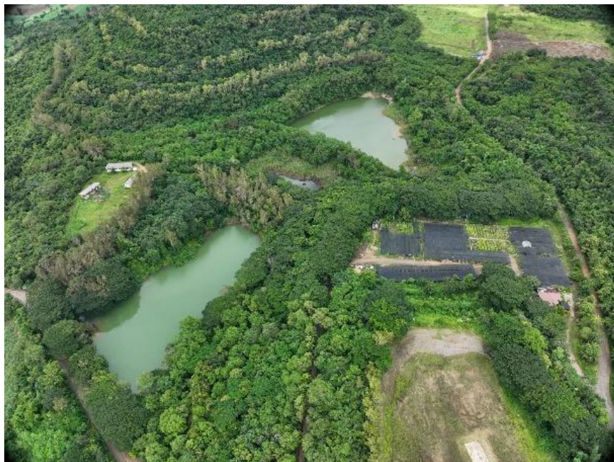
รูปที่ ๑.๓.๑-๖ สภาพพื้นที่ก่อสร้างบริเวณโซน E
