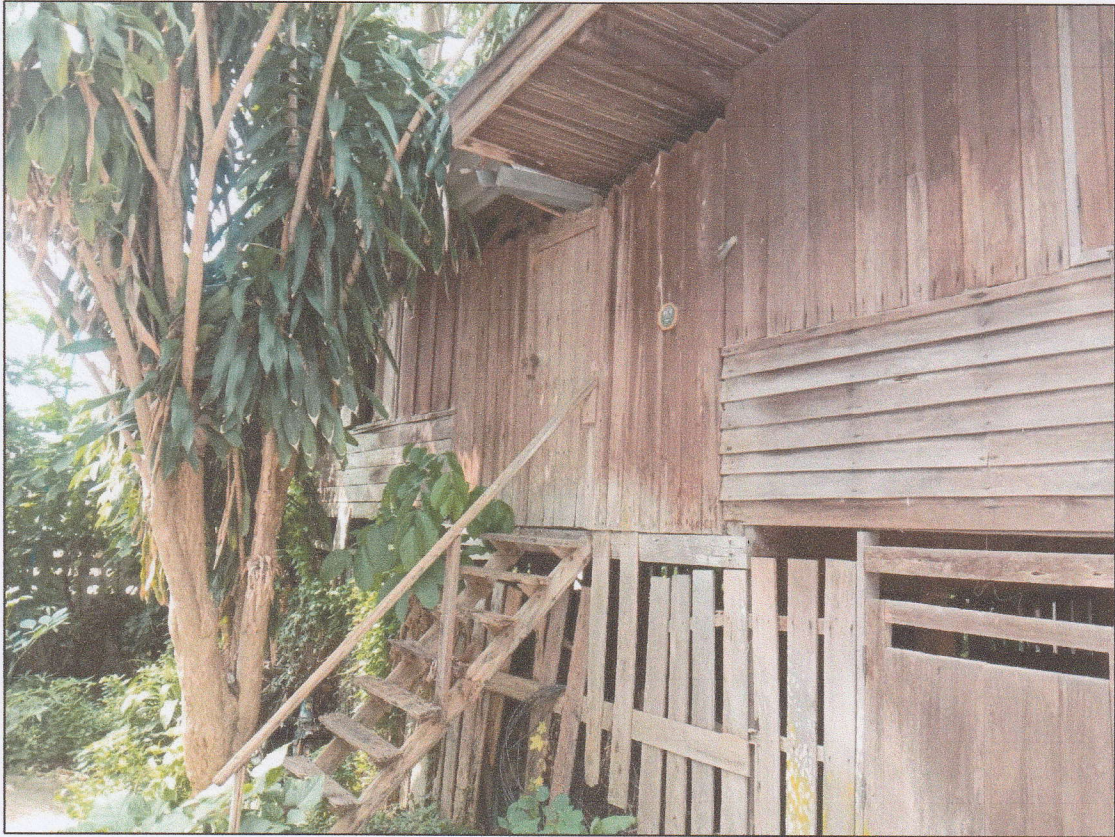
บ้านพักข้าราชการ หลังที่ ๑ บ้านพักไม้ชั้นเดียวใต้ถุนโล่ง ทรงเพิงหมาแหงน ขนาด ๑๒ ตร.ม. เลขที่ราชพัสดุ สป.๑๙๕ (ลำดับที่ ๓)
