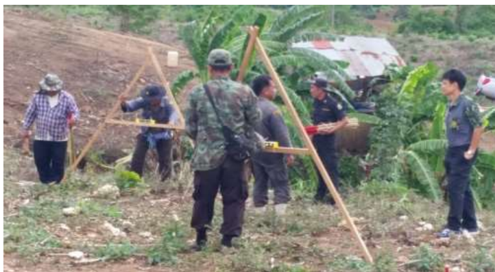
ภาพที่ 11 การปักหลักต่อเนื่องเป็นแนว
