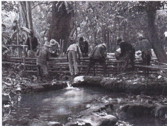
ภาพที่ 14.42 ชุมชนร่วมกันสร้างฝายชะลอน้ำ
