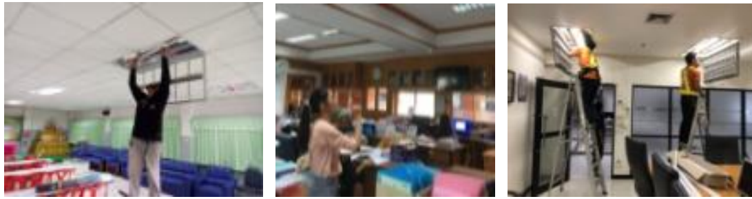
รูปที่ 3-5 ปรับเปลี่ยนหลอดไฟในสำนักงาน
