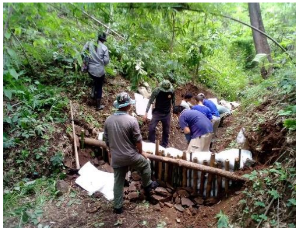
กิจกรรมก่อสร้างฝายต้นน้ำ เพื่อกักเก็บน้ำไว้ใช้ เพิ่มความชุ่มชื้น และดักตะกอนดิน
