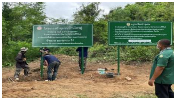
การติดตั้งป้ายโครงการป่าชุมชน และป้ายกฎระเบียบป่าชุมชน ป่าชุมชนบ้านไทรคู่ ม.2 ต.ร่อนทอง อ.บางสะพาน จ.ประจวบคีรีขันธ์
