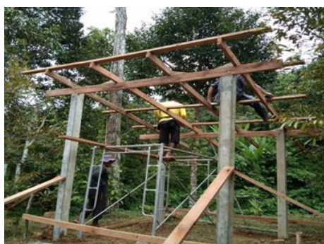
ดูแลรักษาป่าชุมชน สร้างที่พักสายตรวจ
