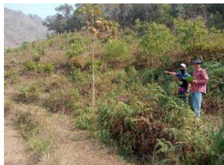
ปฏิบัติงานสำรวจรังวัด และปักหลักแนวเขต
